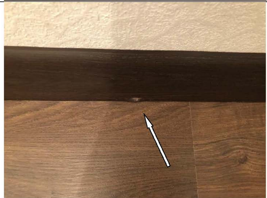
Фото №57. Дефект плинтуса ПВХ кладовой в квартире.
