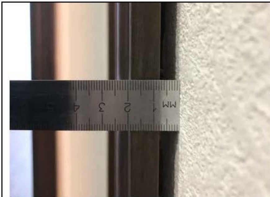
Фото №49. Неплотное прилегание дверного наличника в кладовой квартиры.
