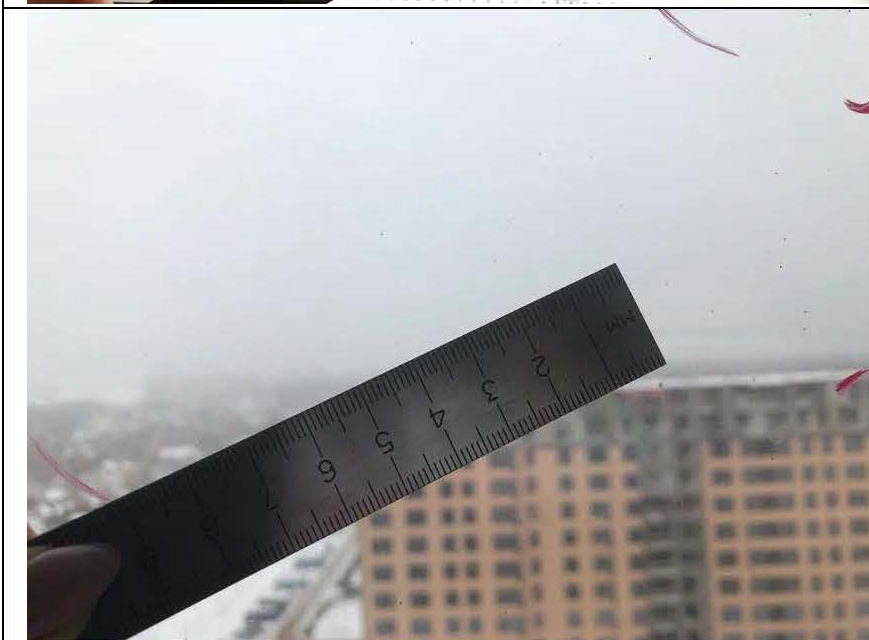
Фото №32. Окалина на стеклопакете оконного блока спальни в квартире.
