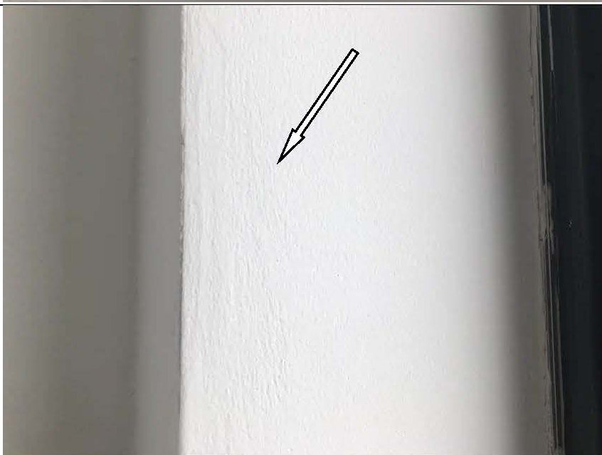
Фото №24. Дефект окрашенного откоса оконного блока на лоджии квартиры.
