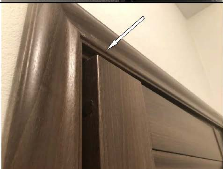
Фото №12. Дверной блок двери кладовой не обеспечивает безотказное открытие/закрытие.
