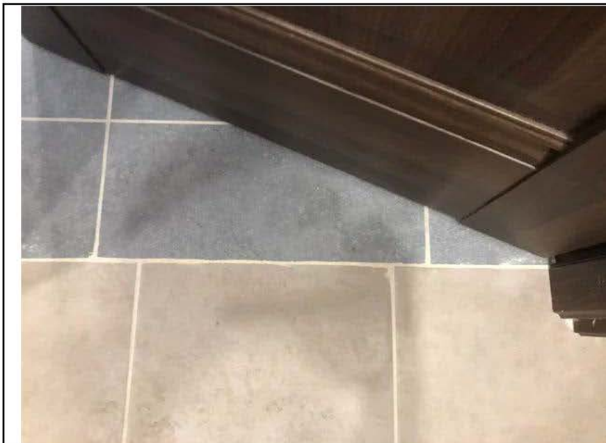
Фото №46. Напольное покрытие в ванной комнате и коридоре на одном уровне.
