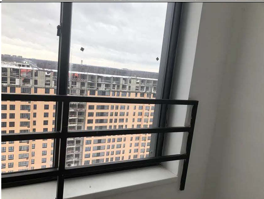
Фото №2. Общий вид лоджии в квартире.
