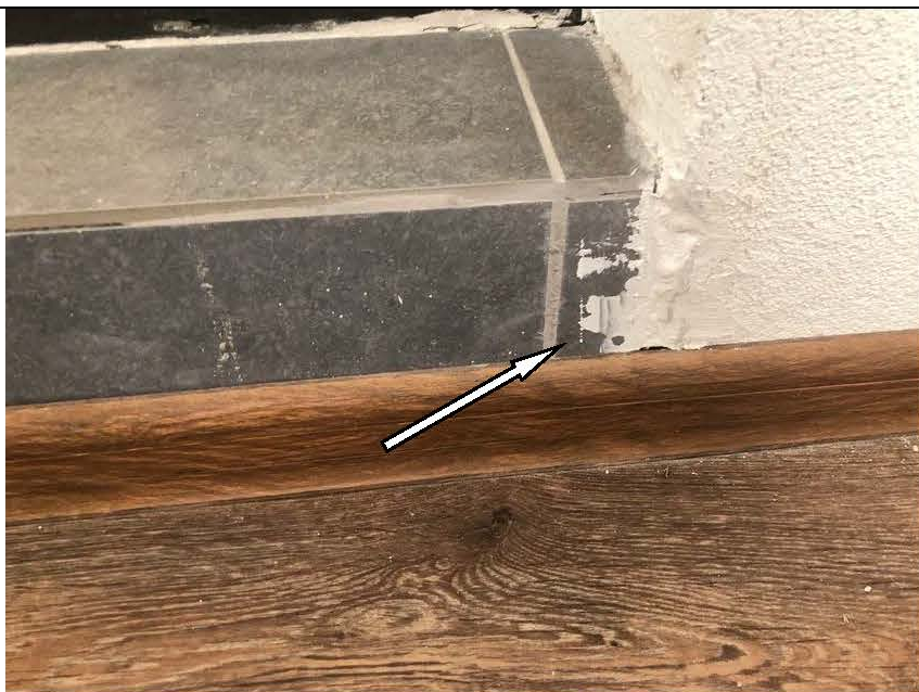
Фото №28. Загрязнение напольной керамической плитки лоджии в квартире.
