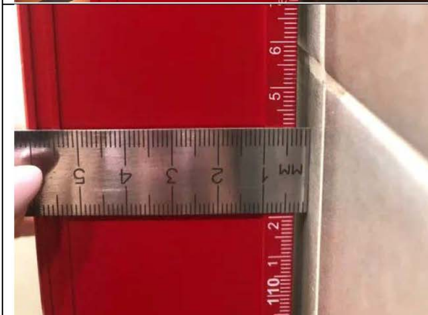
Фото №18. Отклонение уровня плитки стен ванной комнаты в квартире.
