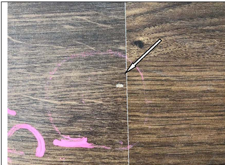
Фото №52. Скол на поверхности ламината спальни в квартире.
