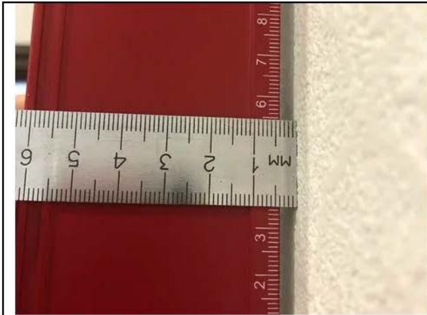
Фото №7. Измерение уровня стен коридора в квартире.
