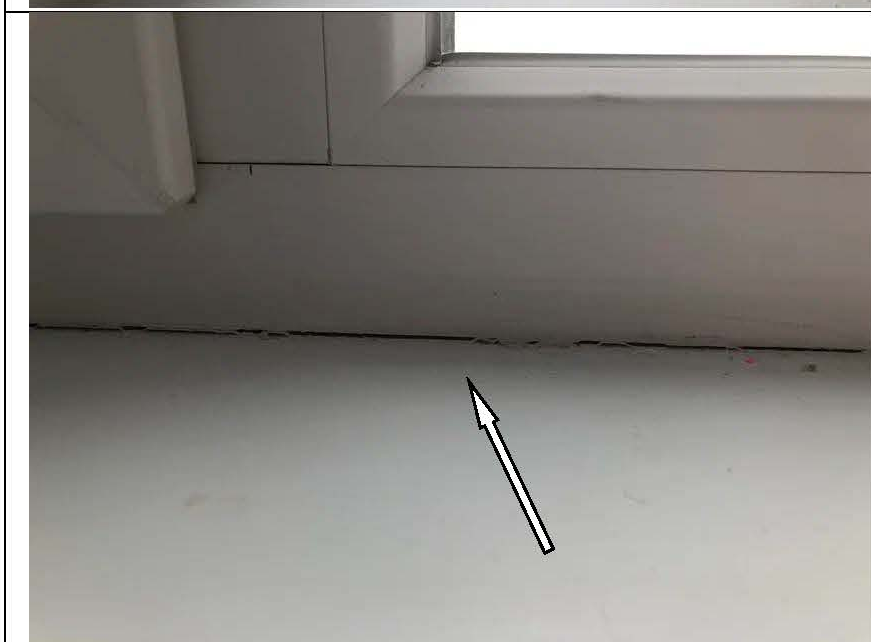
Фото №54. Щель в месте примыкания оконного блока спальни в квартире.
