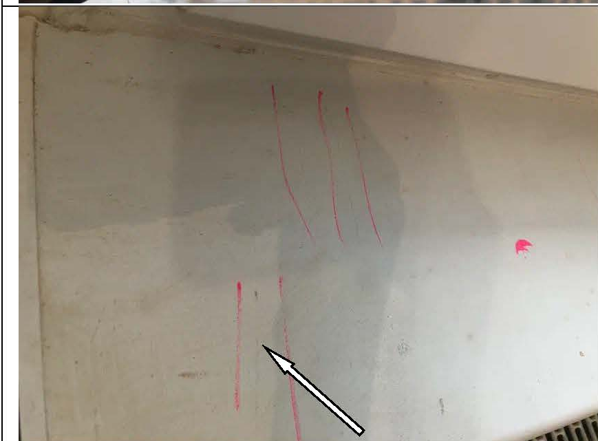
Фото №33. Царапины на лицевой поверхности подоконной доски на кухне квартиры.
