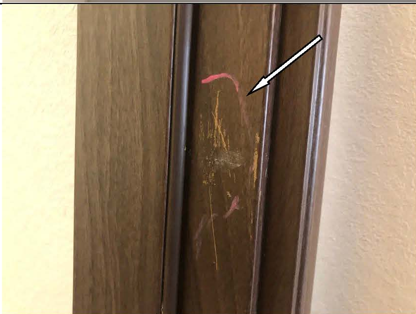
Фото №42. Царапины лицевой поверхности короба дверного блока кухни в квартире.
