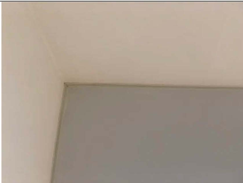
Фото №41. Загрязнение натяжного потолка коридора в квартире.
