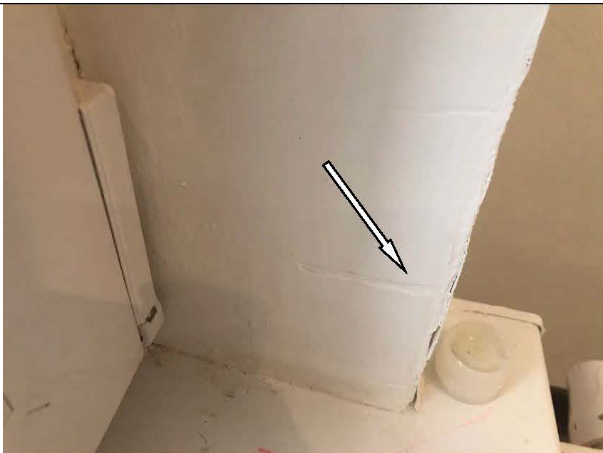
Фото №25. Дефект окрашенного откоса оконного блока на кухне квартиры.
