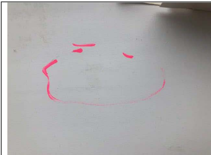
Фото №34. Дефекты на лицевой поверхности подоконной доски в спальне квартиры.
