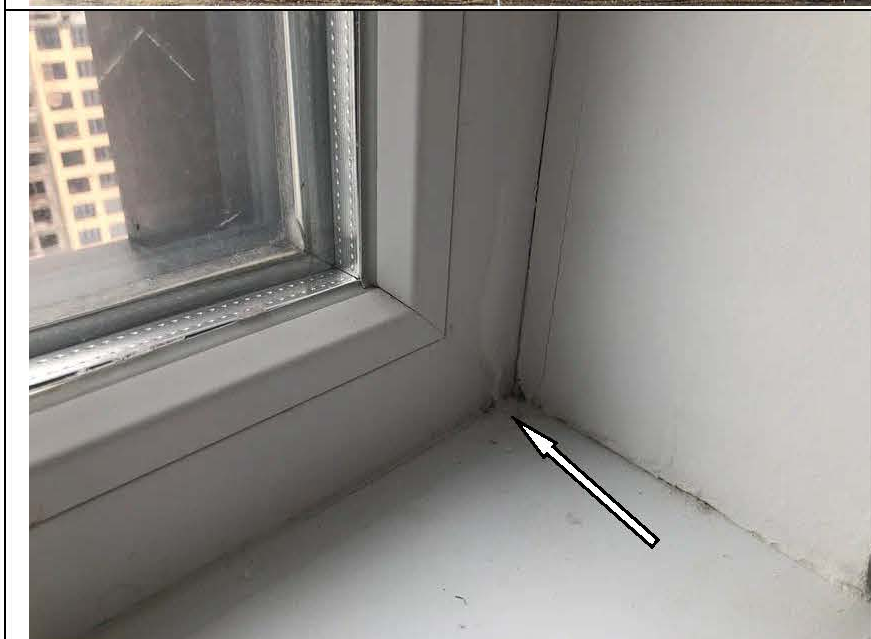
Фото №53. Щель в месте примыкания оконного блока спальни в квартире.
