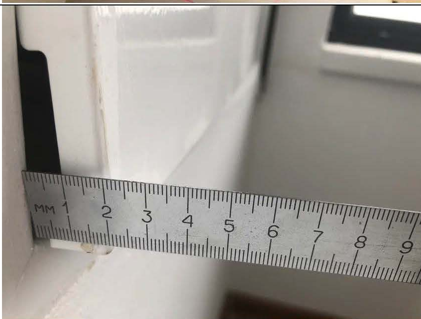
Фото №26. Зазор между стеной и сантехническим люком лоджии в квартире.
