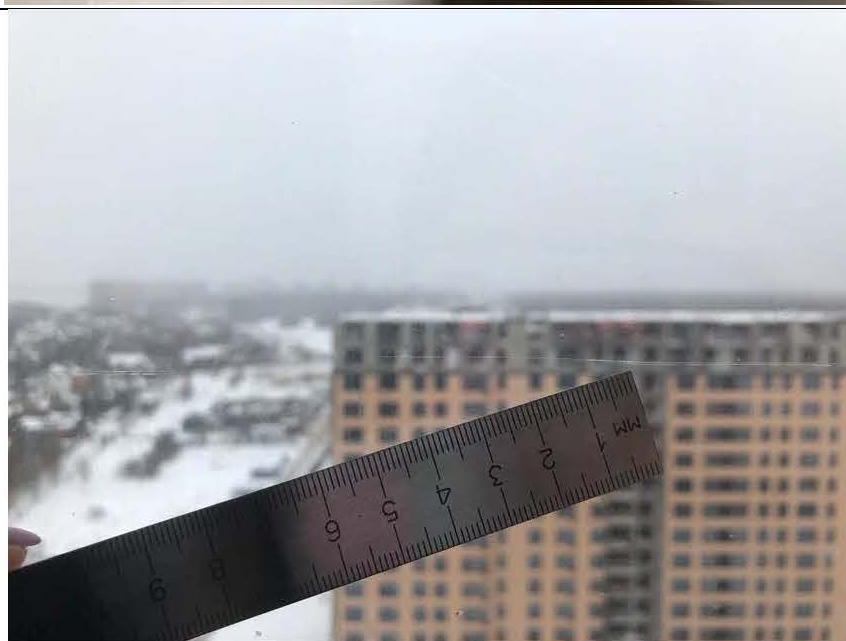
Фото №27. Царапина на стеклопакете оконного блока лоджии в квартире.
