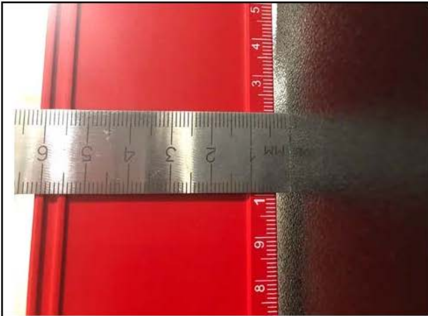
Фото №13. Отклонение полотна входного дверного блока в квартире.
