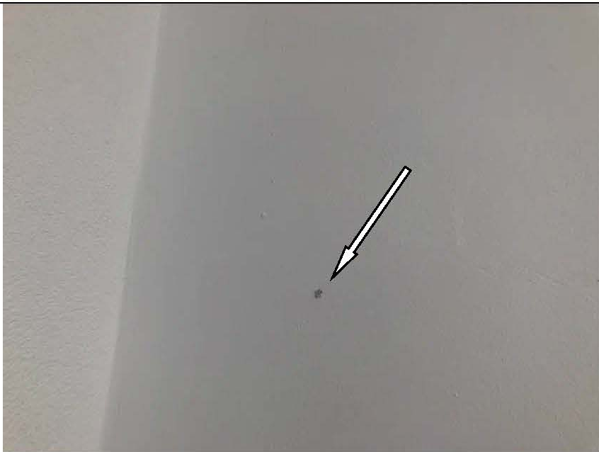
Фото №23. Дефект окрашенного потолка лоджии в квартире.
