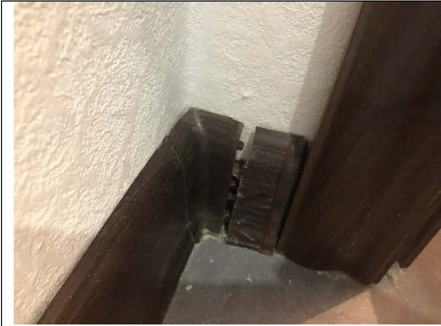
Фото №58. Дефект плинтуса ПВХ коридора в квартире.
