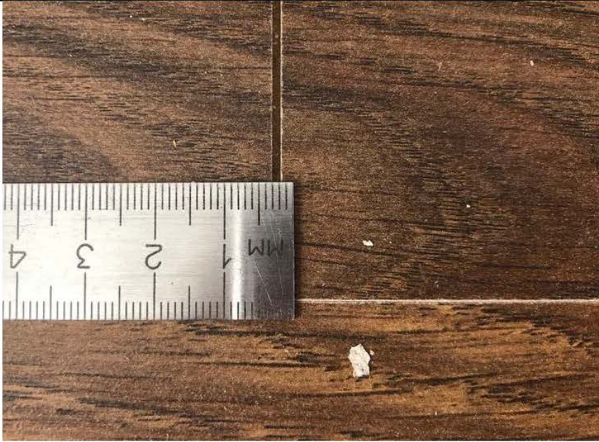
Фото №55. Зазор между смежными досками ламината в спальне квартиры.
