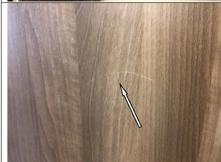
Фото №44. Дефекты дверного полотна ванной комнаты в квартире.
