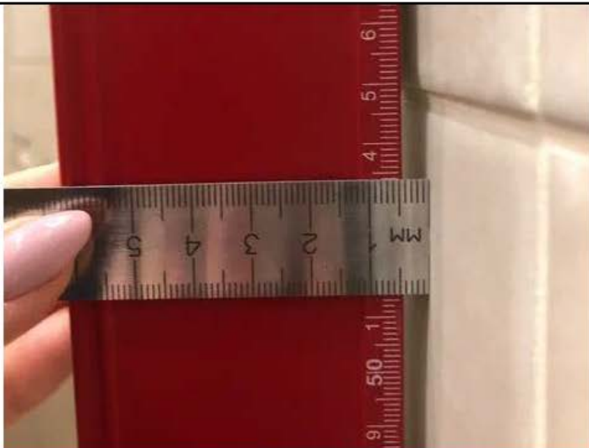
Фото №19. Отклонение уровня плитки стен ванной комнаты в квартире.
