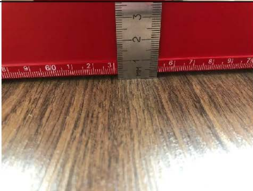
Фото №20. Измерение уровня ламината пола спальни в квартире.
