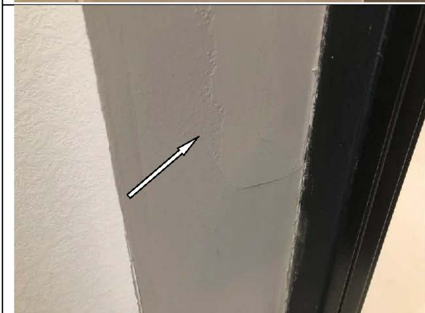
Фото №48. Дефект окрашенного откоса блока входной двери в квартире.
