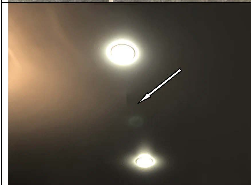
Фото №39. Видимость инженерных сетей на натяжном потолке кухни в квартире.
