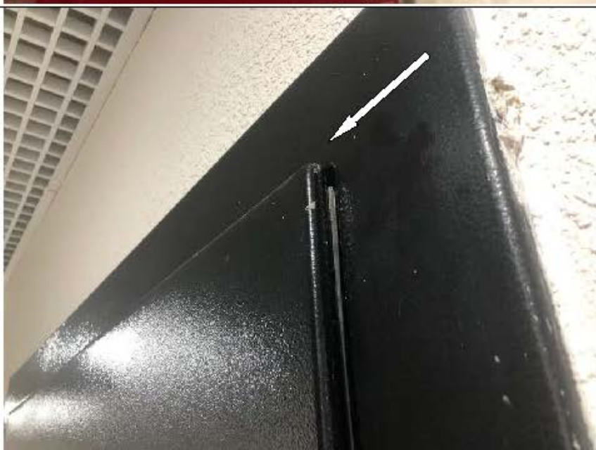
Фото №11. Дверной блок входной двери не обеспечивает безотказное открытие/закрытие.
