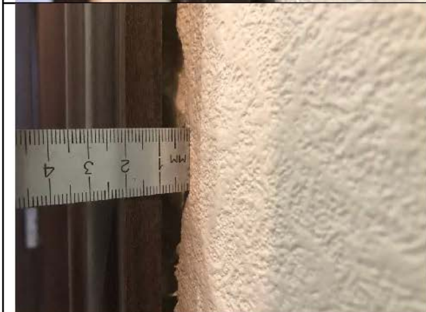
Фото №50. Неплотное прилегание дверного наличника в спальне квартир.
