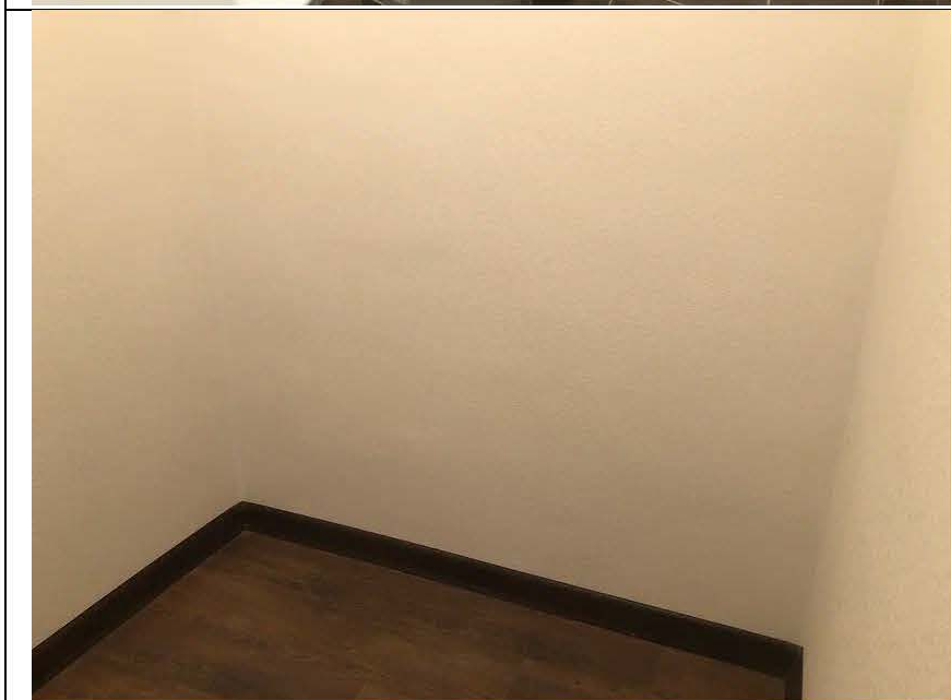
Фото №6. Общий вид кладовой в квартире.
