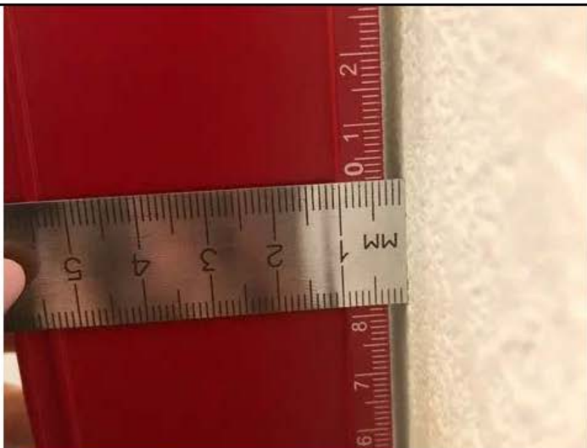
Фото №10. Измерение уровня стен кухни в квартире.
