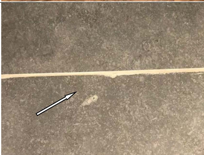
Фото №29. Загрязнение и неровный шов напольной керамической плитки на кухне квартиры.
