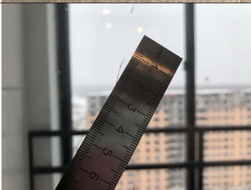
Фото №30. Царапина на стеклопакете оконного блока кухни в квартире.
