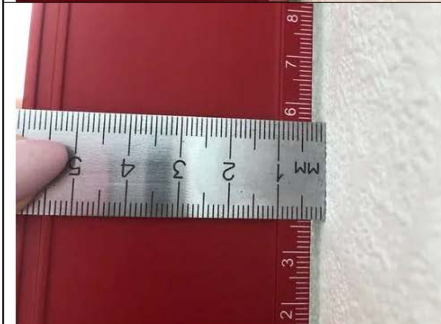
Фото №9. Измерение уровня стен спальни в квартире.
