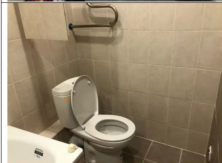
Фото №5. Общий вид ванной комнаты в квартире.
