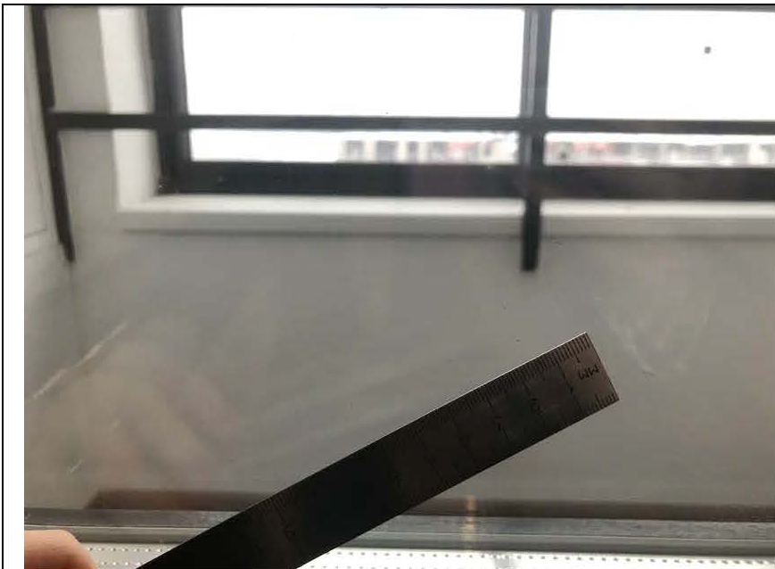
Фото №31. Окалина на стеклопакете оконного блока кухни в квартире.
