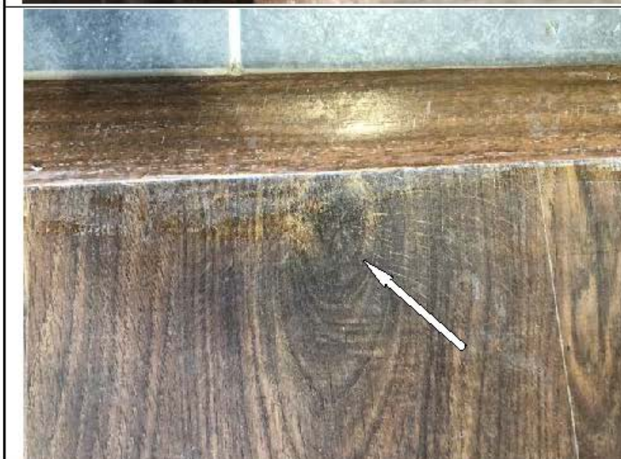
Фото №51. Загрязнение на поверхности ламината спальни в квартире.
