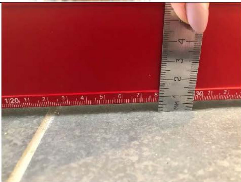
Фото №21. Измерение уровня плитки пола кухни в квартире.
